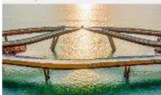
สะพานจูป
